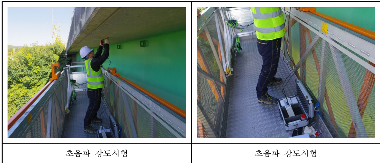
〈사진 3.20〉 초음파시험 측정 현황
