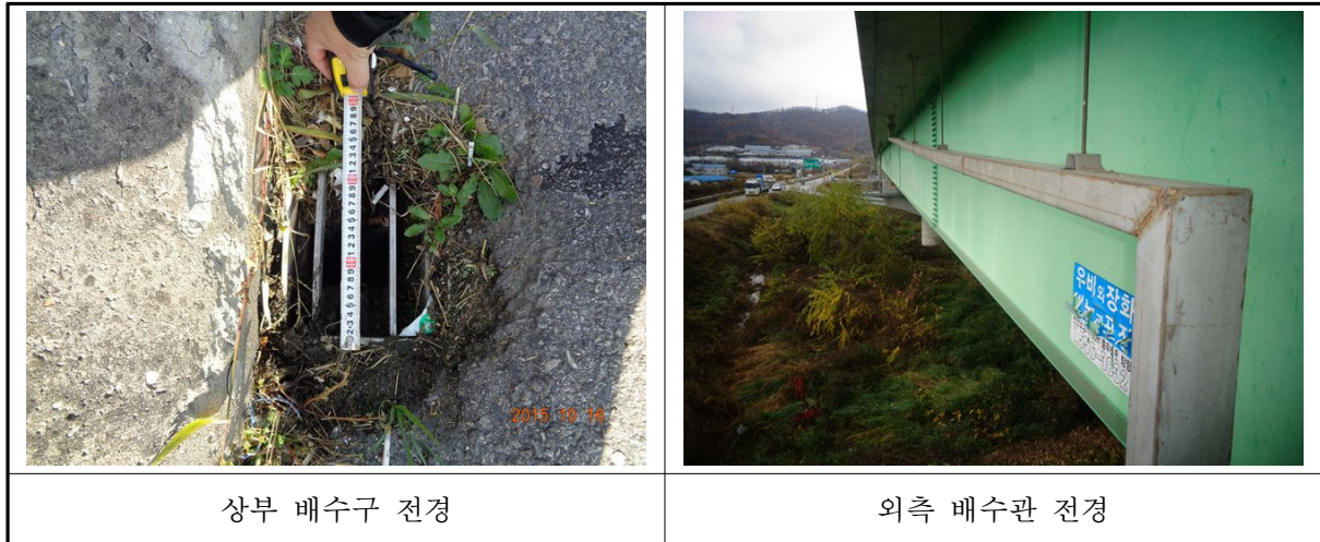
〈사진 3.6〉 배수시설 전경
