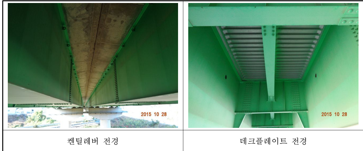
〈사진 3.11〉 바닥판하면 전경
