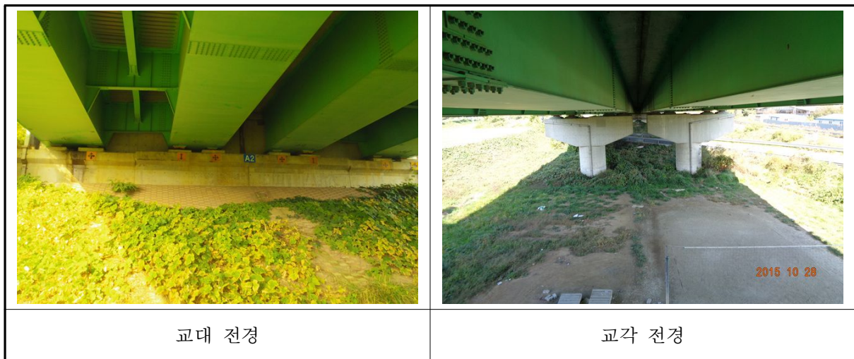
〈사진 3.17〉 교대 및 교각 전경
