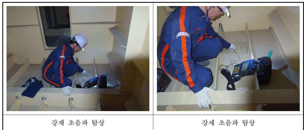
〈사진 3.27〉 강재 초음파탐상시험 현황
