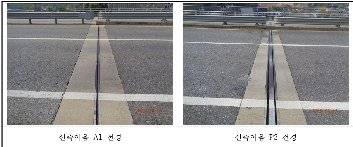
〈사진 3.8〉 신축이음 전경
