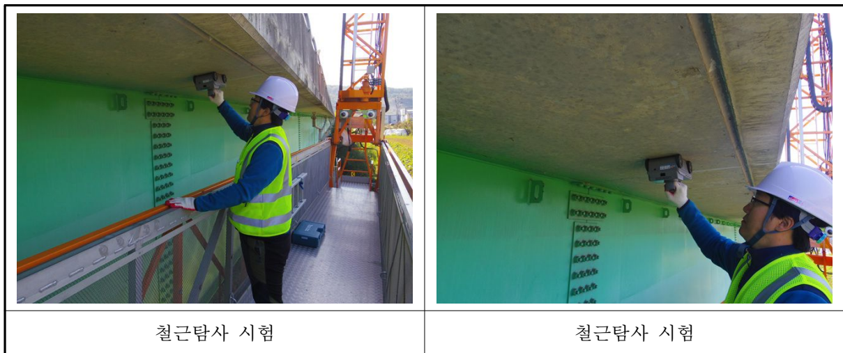
〈사진 3.22〉 철근탐사 현황
