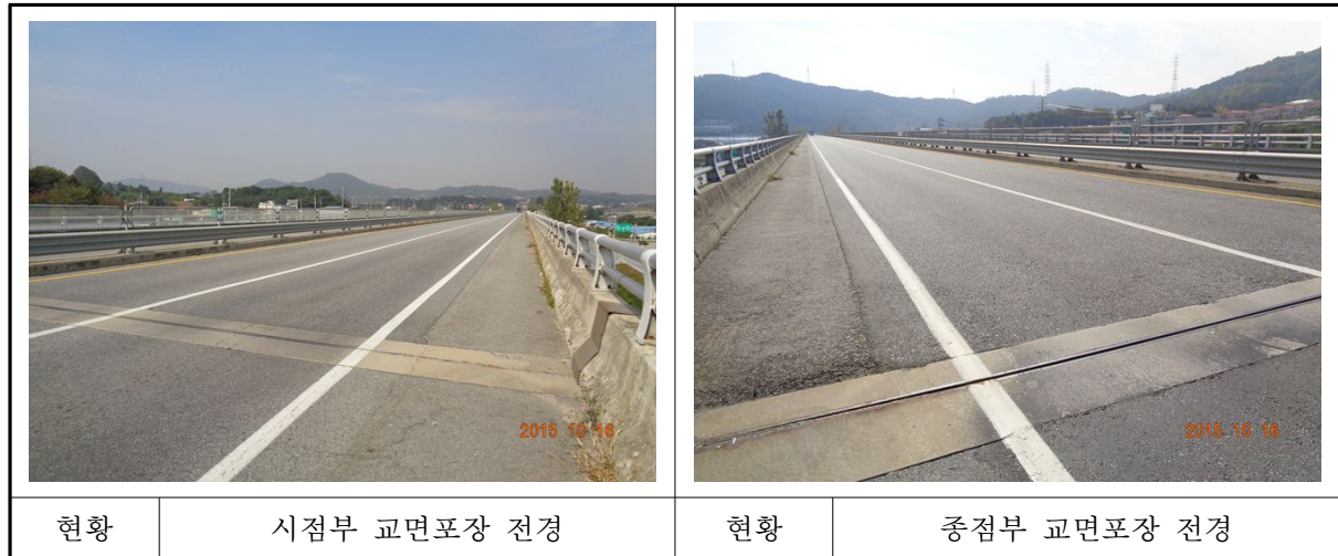
〈사진 3.2〉 교면포장 전경
