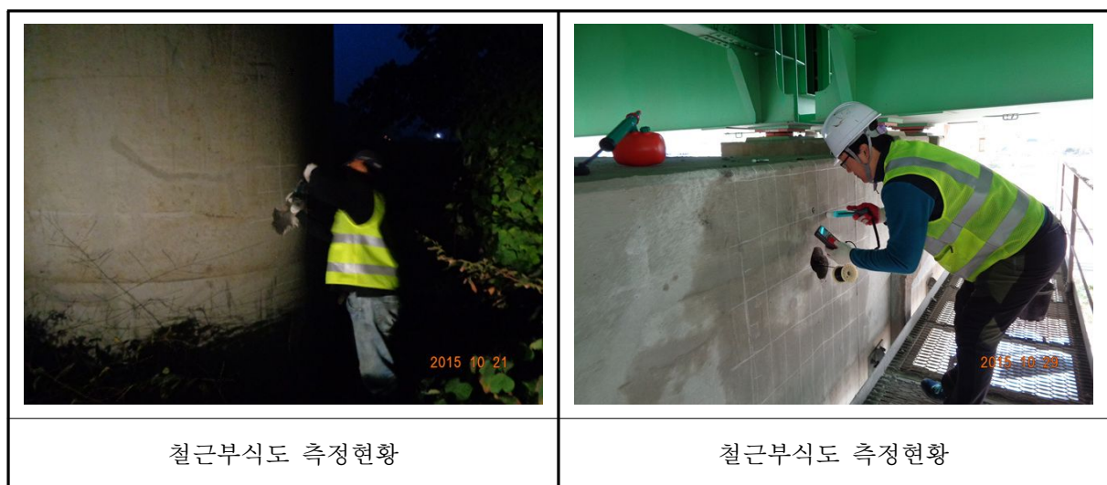
〈사진 3.26〉 철근부식도 현황
