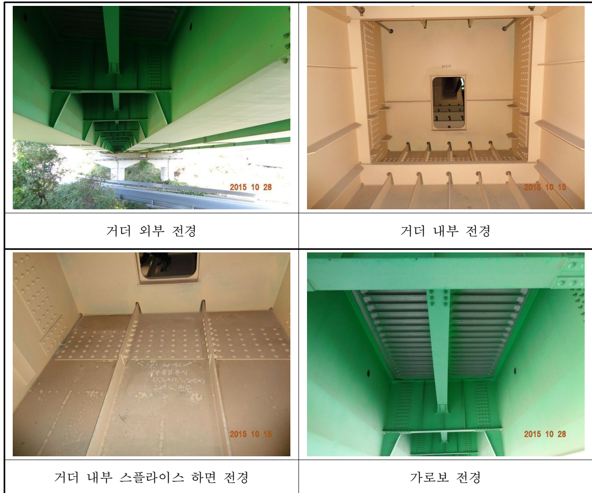
〈사진 3.13〉 거더 및 가로보 전경
